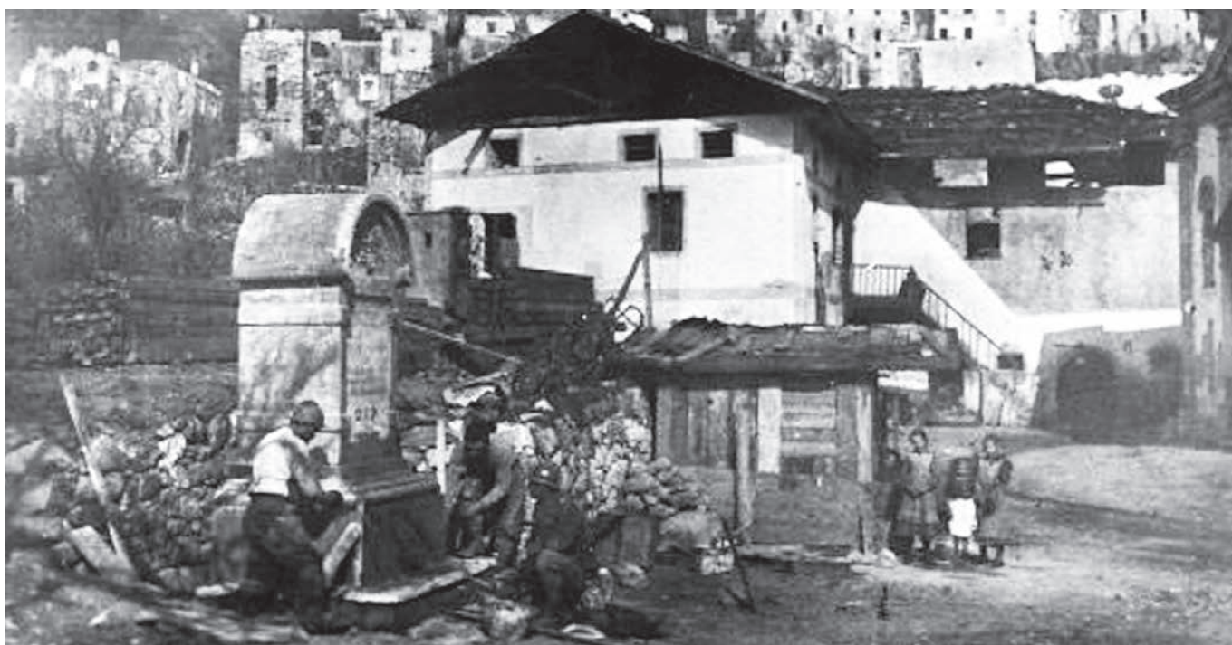
Carzano: la costruzione del monumento ai bersaglieri caduti il 18 settembre 1917, nella piazza della chiesa
