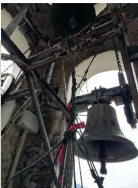
Il nuovo apparato meccanico del campanile
