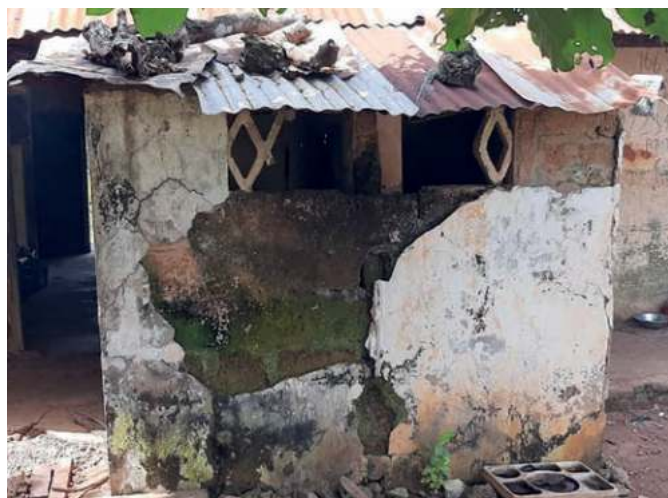
Uno dei bagni da ristrutturare
